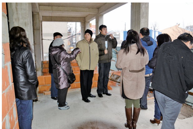
客户参观施工现场
